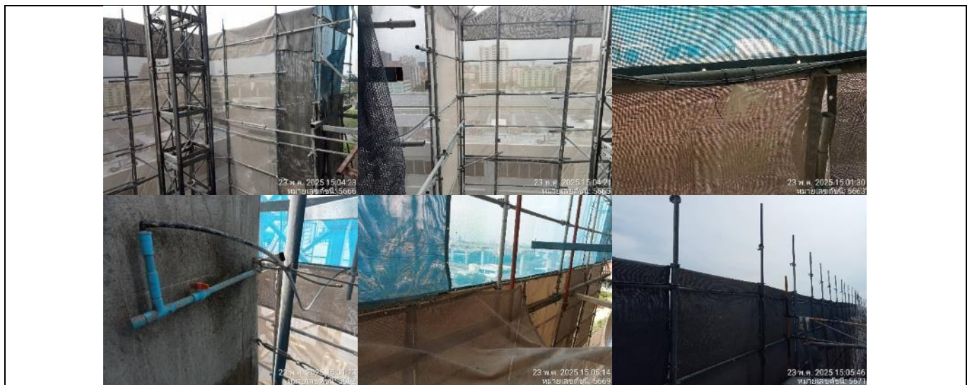
รูปที่ ผ7.52 หัวฉีดสเปรย์น้ำ (Spray nozzles) บนอาคารย้ายไปตามชั้นที่มีการก่อสร้าง
